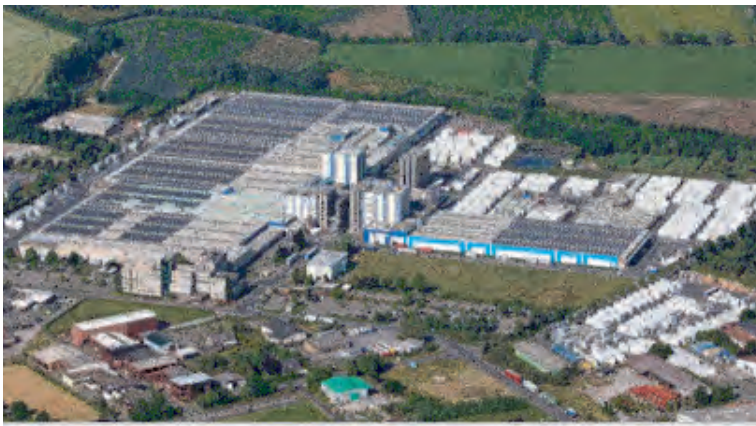
Firmengelände der VEKA AG in Sendenhorst
